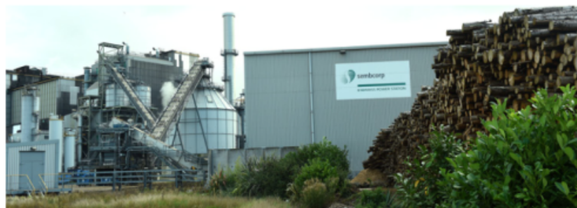
上图：Norcem Brevik 水泥厂，属于北欧光CCS项目的一部分。图片来源：Norcem 下图：胜利能源美国生物能源发电站，位于Teesside的Wilton International工业区。图片来源：胜利能源美国
