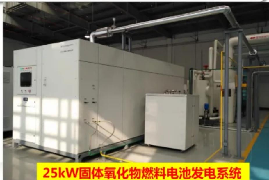
25kW固体氧化物燃料电池发电系统
