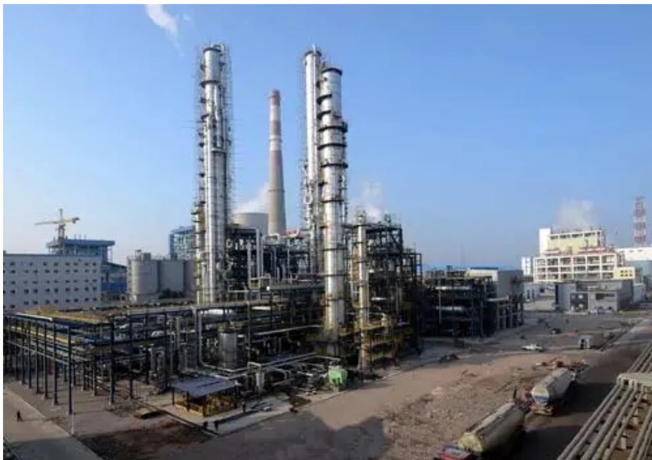
茂名石化投建的国内单产能力最大的煤制氢装置
