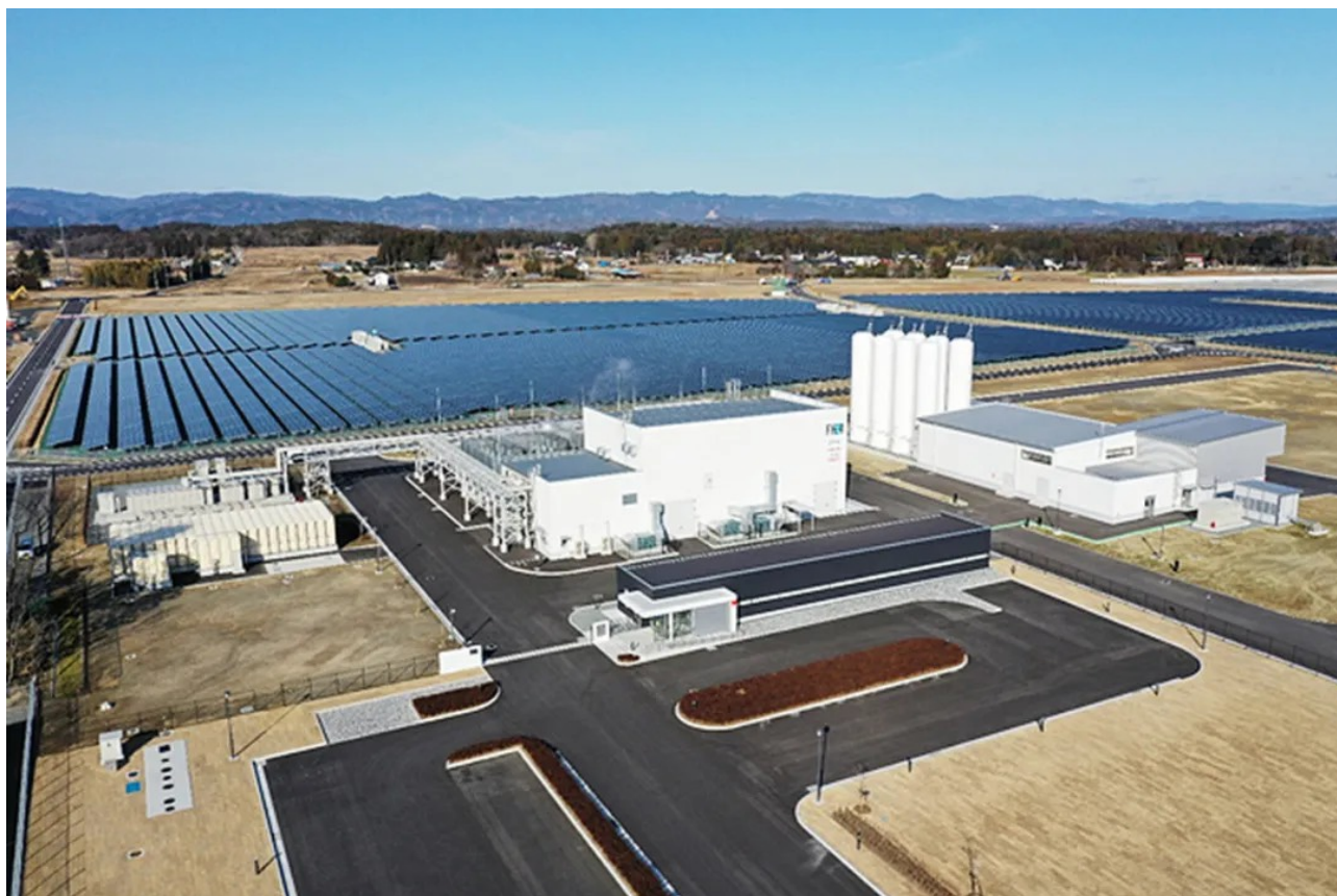
日本福岛县太阳能制氢项目（全球最大的光伏制氢项目）
