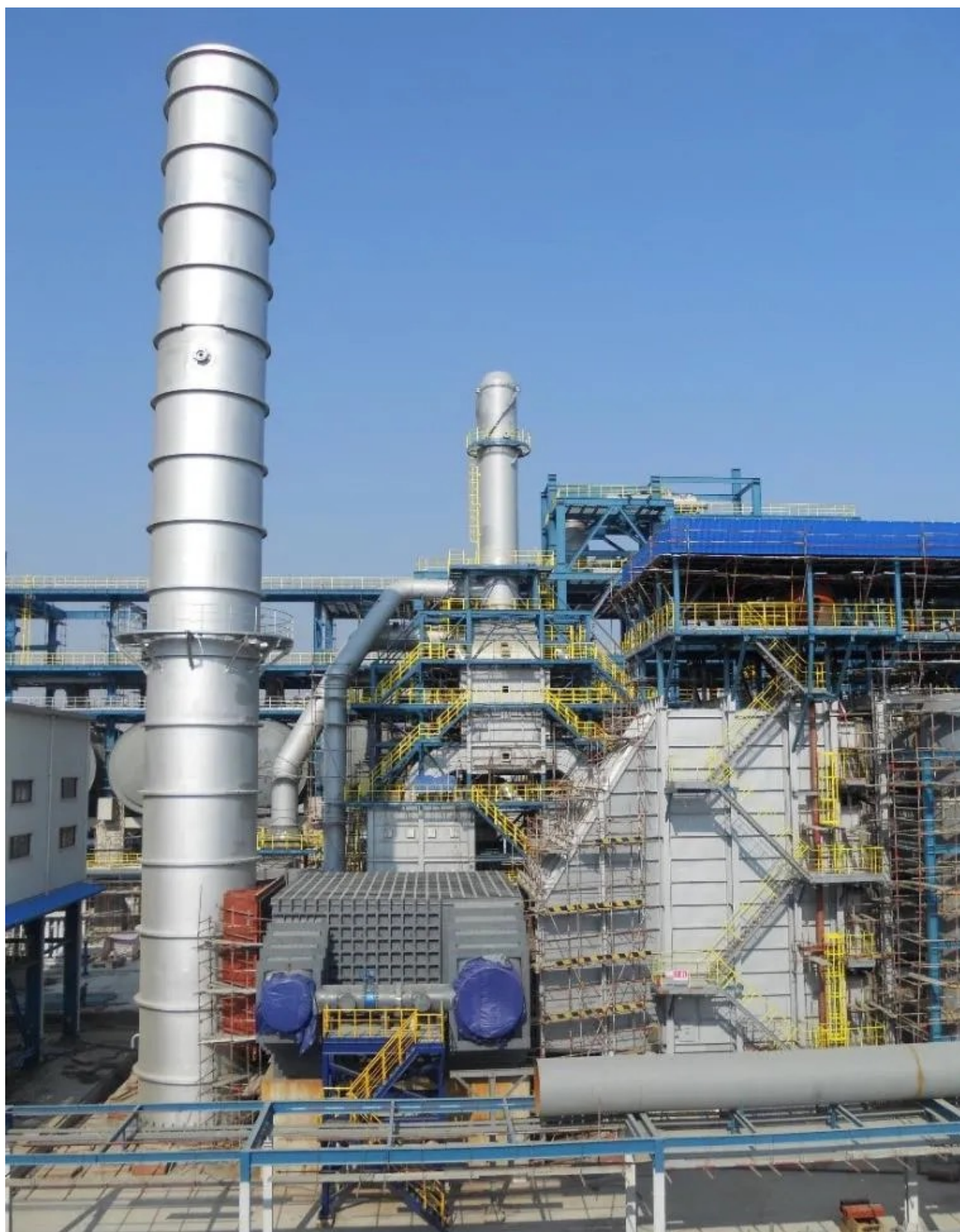
中国化学工程第三建设有限公司承建的全球单套产能最大的 丙烷脱氢项目
