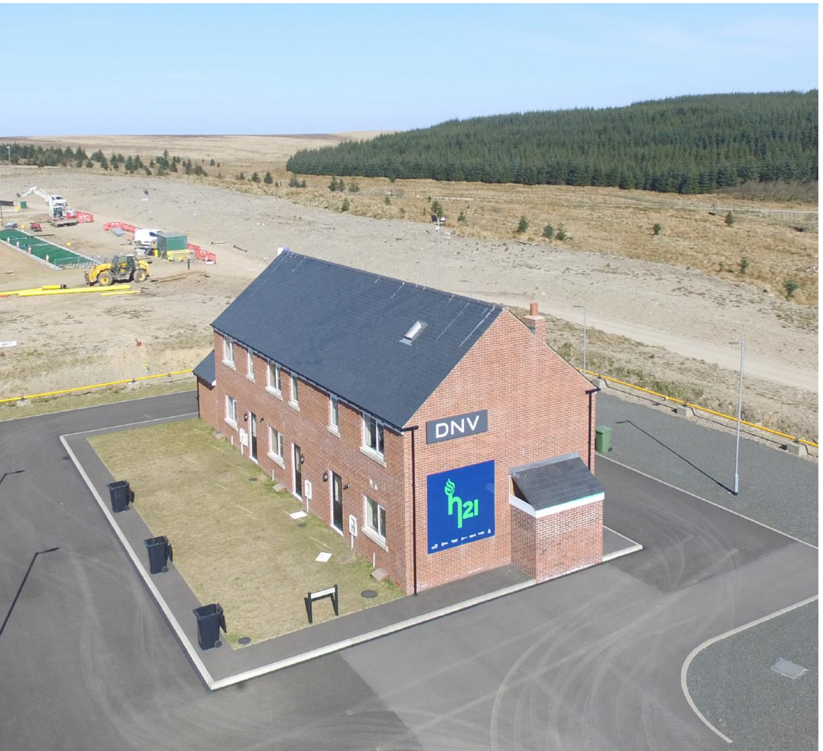
DNV的HyStreet设施位于世界上最完整的陆上氢使用示范区的尽头。HyStreet展示了为国内终端用户提供100%的氢锅炉供暖，Northern Gas Network的H21项目展示了低于7 barg的氢气配送，National Grids的在建项目FutureGrid设施将展示大直径、高压系统（高达至70 bar）的氢气运输
