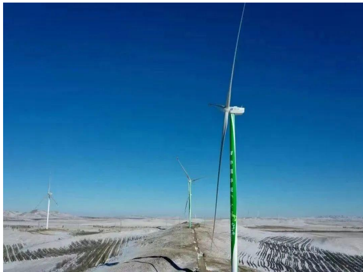
图“风光火储”耦合发电的基地型规模化综合能源项目
